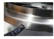
ケーブルは、側面下の欠きこみ部分より取り出す、露出しケーブルは モール・FP管などで保護
